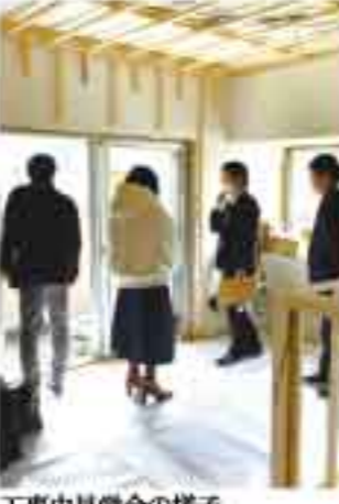
工事中見学会の様子
